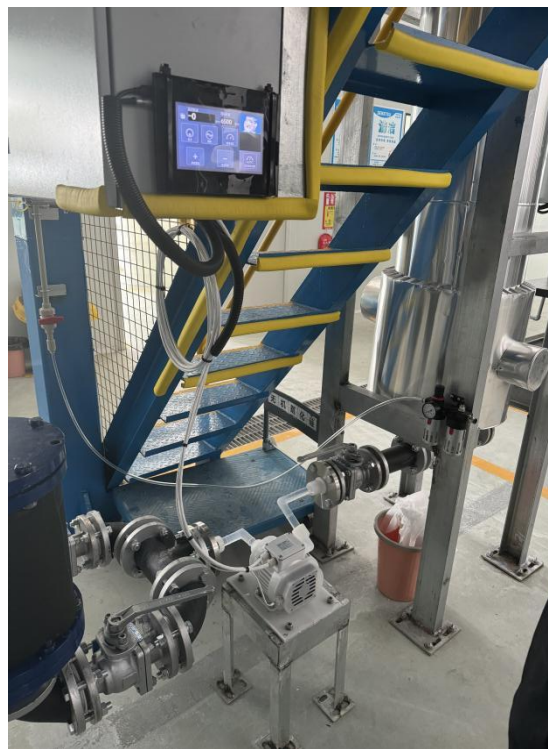
图 4 化工 CDS（化学品配送系统）输送
